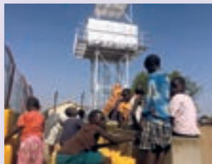
太陽光パネル式給水施設の改修
